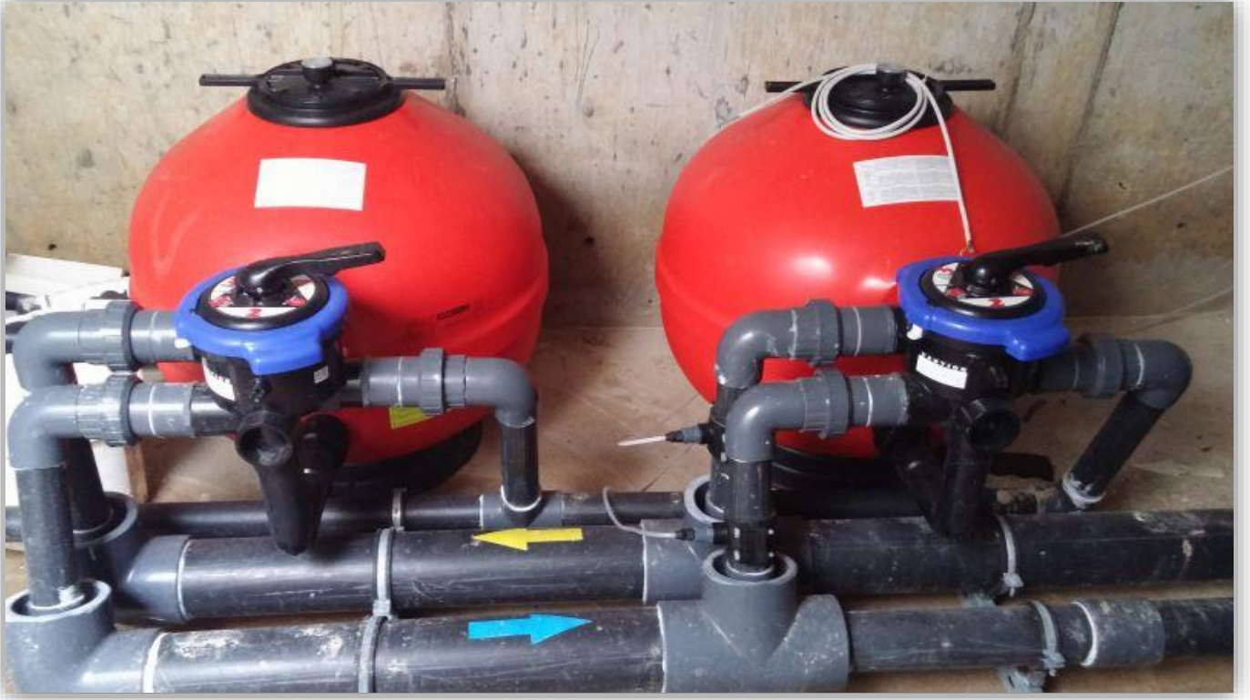
Havuz Filtrasyon Sistemlerimizden Bir Örnek
