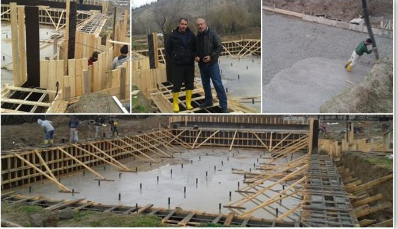
Havuz Betonarme ve Mekanik Tesisat İşlerimizden Örnekler
