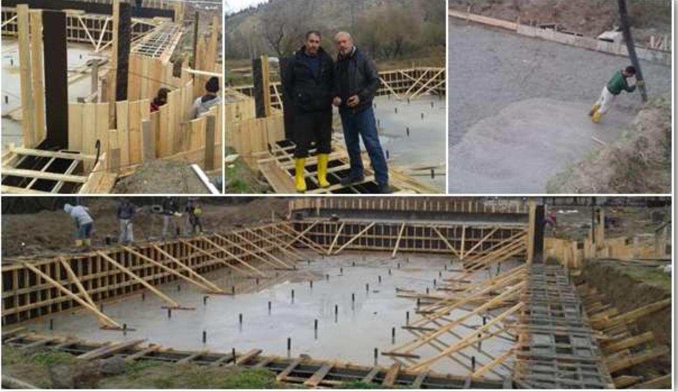
Havuz Betonarme ve Mekanik Tesisat İşlerimizden Örnekler
