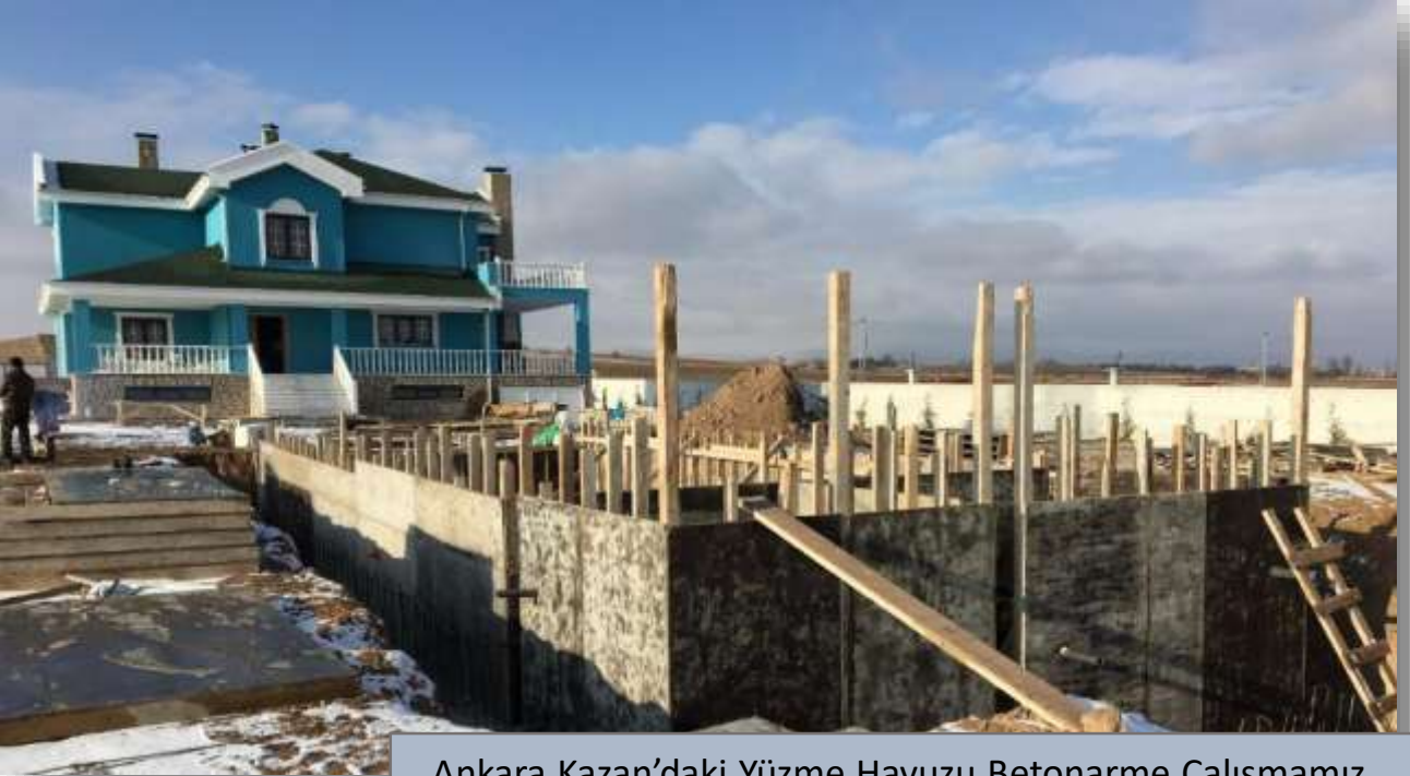
Ankara Kazan'daki Yüzme Havuzu Betonarme Çalışmamız
